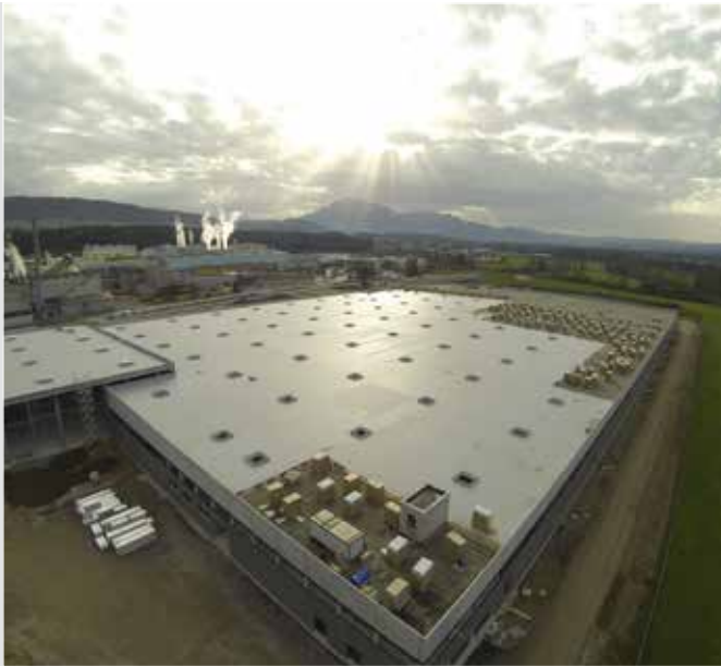
Aldi centre logistique 50000m2 TPO Membrane, Suisse
