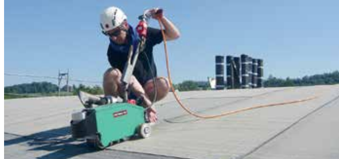
Le BITUMAT B2 soude du bitume en élastomère sans flamme.
