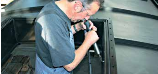
DIODE PID lors d'un soudage rapide sur un réservoir en PE.
